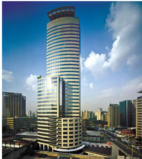
Figura 2.5 – Edifício E-Tower. São Paulo, SP. Disponível em: http://www.spcorporate.com.br/
