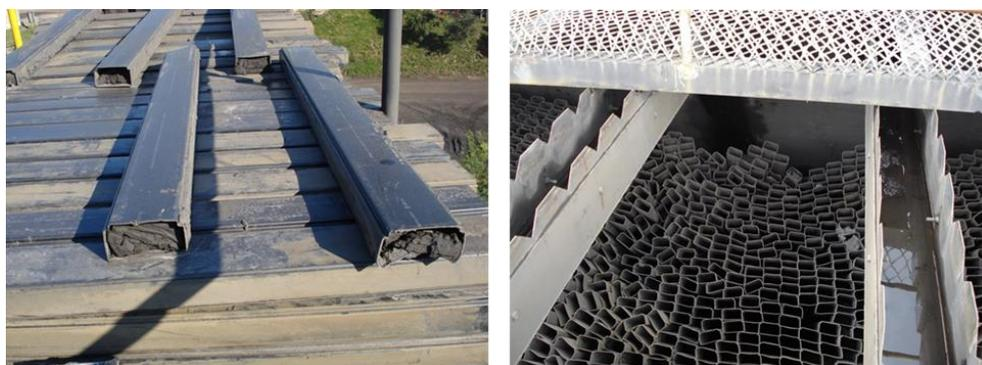
Figura 26 - Lamelas obstruídas e desabamento dos pacotes.
