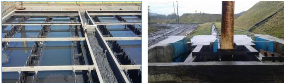
Figura 31 - Superfície dos sedimentadores mostrando os vertedouros de esgotamento e as calhas de medição de vazão do clarificado.
