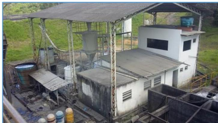
Figura 32 - Sistema de preparação de leite de cal e solução floculante.
