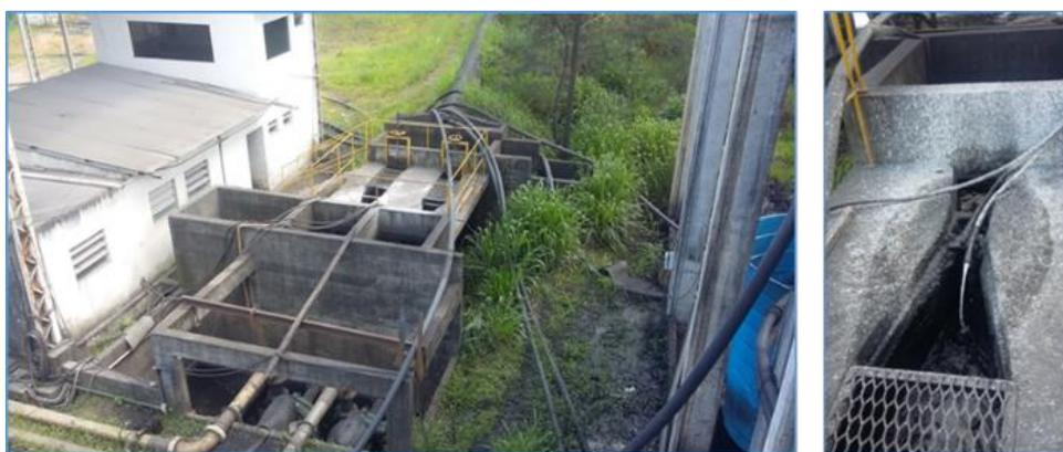
Figura 28 - Calhas Parshall de medição do fluxo de entrada nos espessadores.
