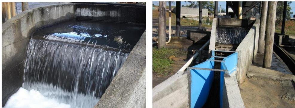
Figura 25 - *Overflow* clarificado vertendo no sistema de amortecimento e sendo descarregado em uma calha de medição de vazão tipo Parshall.
