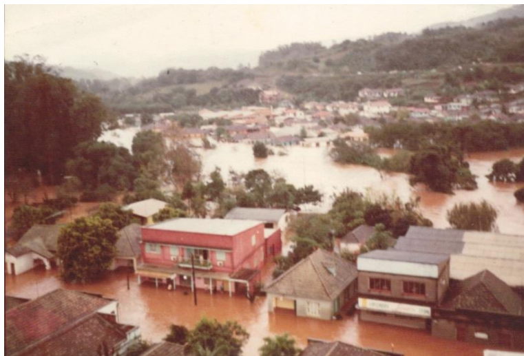
Figura 40: Inundação ocorrida no ano de 1992. Fonte: Fundação Cultural de Igrejinha
