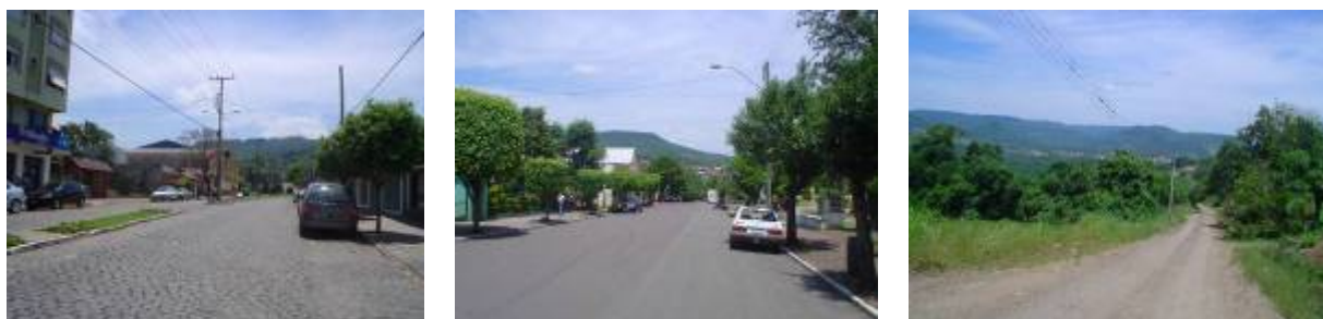
Figura 23: fotos das vias na zona urbana. (a) via de paralelepípedo; (b) via asfaltada; (c) via sem pavimentação
