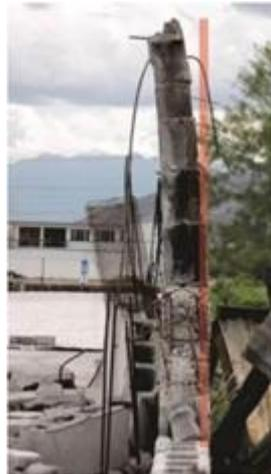
Figura 11 – Inclinação de um muro de alvenaria devido às ações térmicas (NAVARRO; AYALA, 2015).
