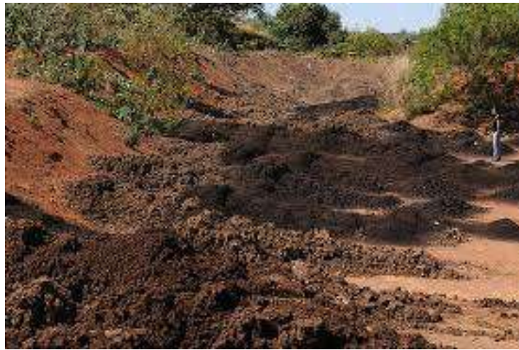
Figura 3.7: uso de lodo na recuperação de uma área degradada.
