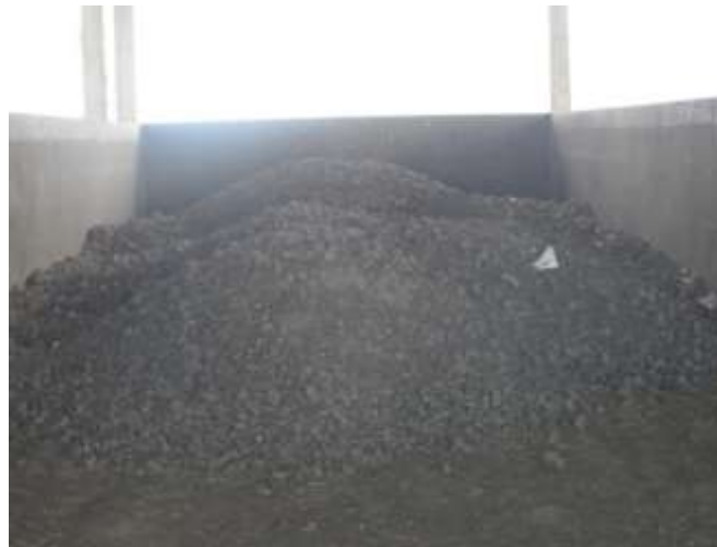
Figura 3.11: galpão de armazenamento do lodo de ETE, na cidade da Beira, Moçambique.
