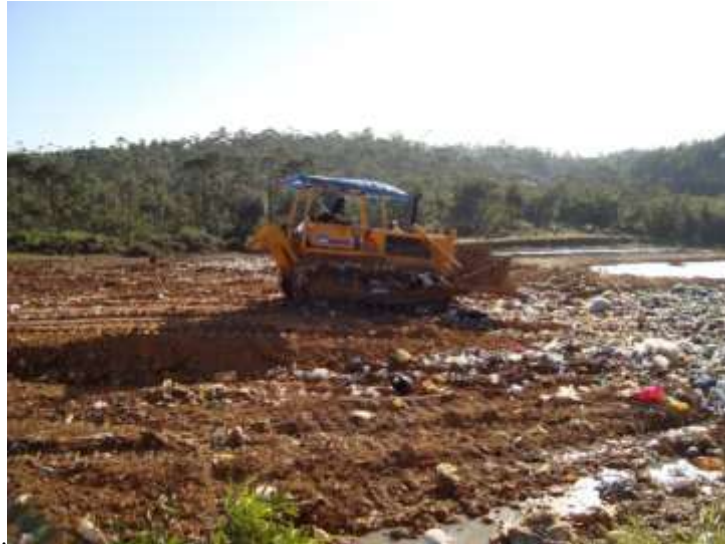
Figura 3.6: disposição do lodo em aterro sanitário.
