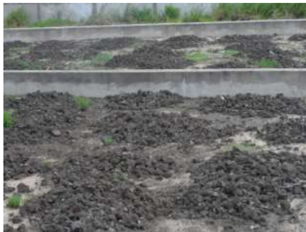
Figura 3.10: leito de secagem do lodo de ETE na Cidade da Beira, em Moçambique.
