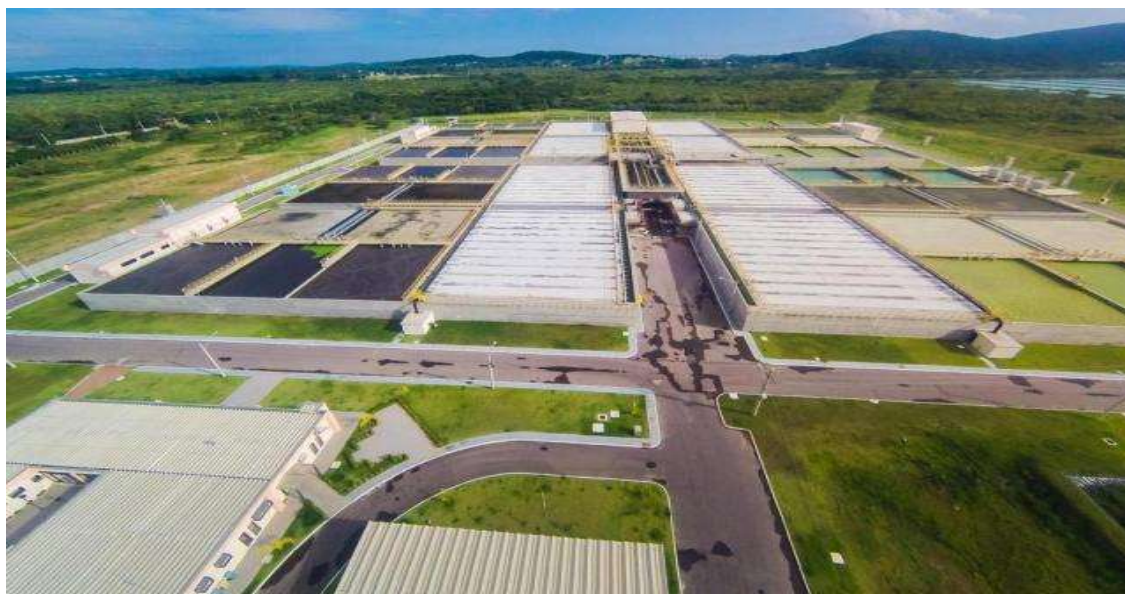
Figura 4.4: vista aérea da ETE Serraria.
