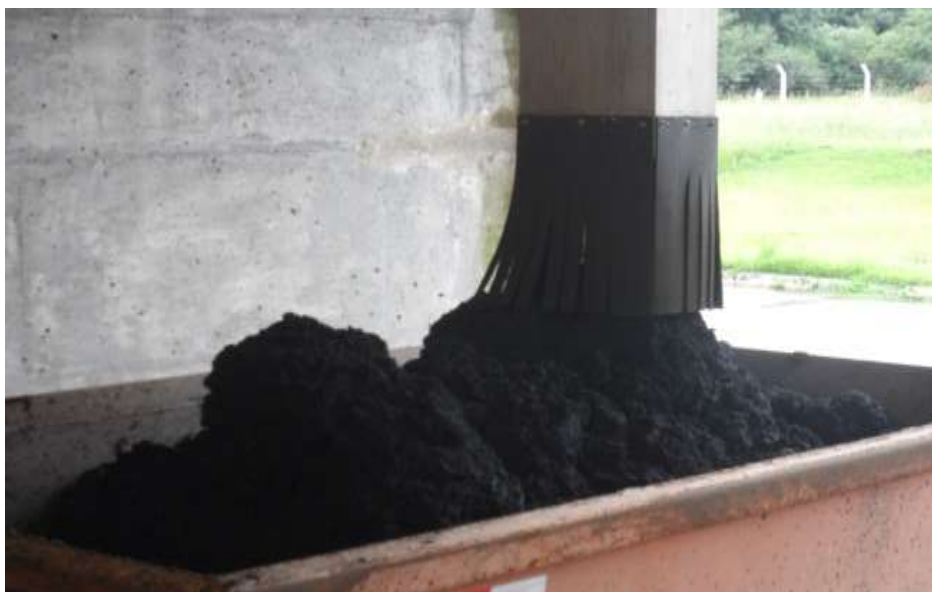
Figura 4.5: descarga do lodo desaguado em contêiner para destinação licenciada.
