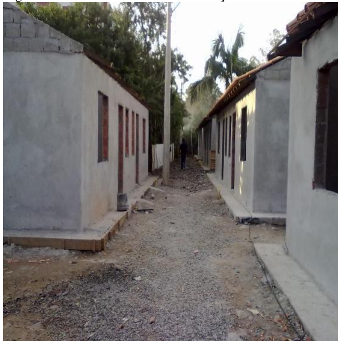
Figura 9 - As 24 novas casas em construção em 2012
