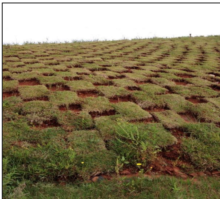
Figura 55 - Plantio de grama, obra do PRAD, 2015. Aterro/lixão, Santa Tecla, Gravataí/RS
