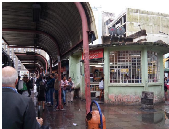
Antigo abrigo do terminal de ônibus onde atualmente funcionam lanchonetes. Junto dele, as proteções das paradas atuais.
