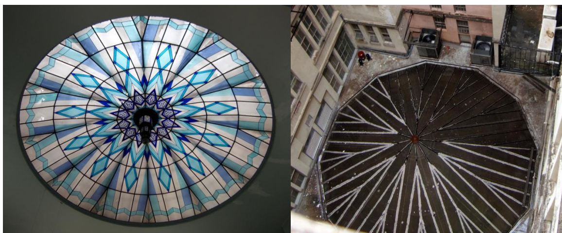
José Lutzenberger (1882–1951) Cúpula do Palácio do Comércio vista interior e exterior | Fotos da autora A vista exterior demonstra que se trata de vidro pintado com técnica de vitral e não vidro colorido.
