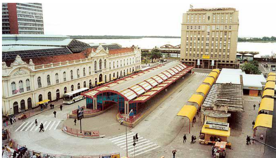
Borelli & Merigo Arquitetura e Urbanismo Terminal Parobé, Porto Alegre, anos 2000 Disponível em
