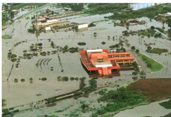
Figura 5.12: Inundação de 2004: ocupação pelas águas da planície de inundação do Canal Santa Bárbara, no local da rodoviária de Pelotas (PMPel, 2004)
