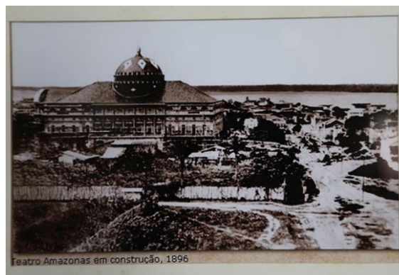
Figura 3: Teatro Amazonas em construção, 1896 14 .
