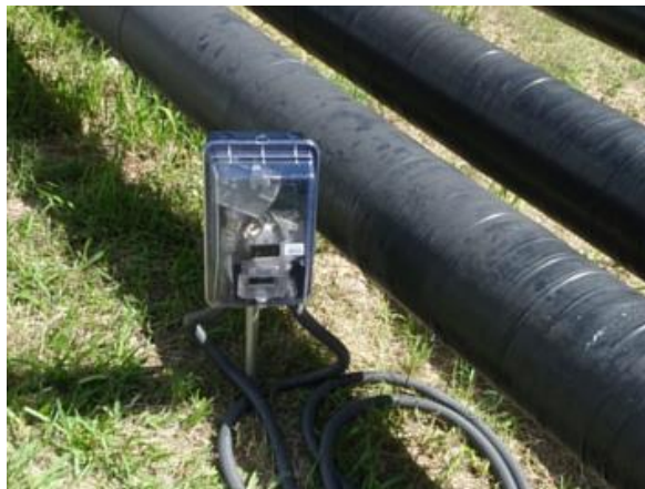
Figura 54 – Caixa de acondicionamento dos conectores elétricos do colar após o enterro.
