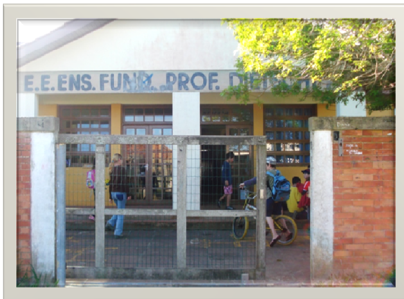
Figura 91 – Fachada da E.E.E.F. Dietschi (30/10/2008)
