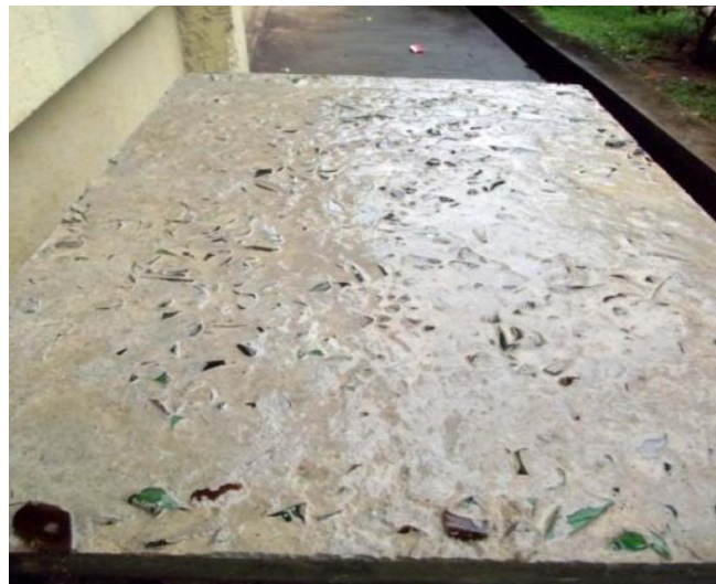
Figura 3.2: painel de concreto para acabamento com a utilização de vidro como agregado.
