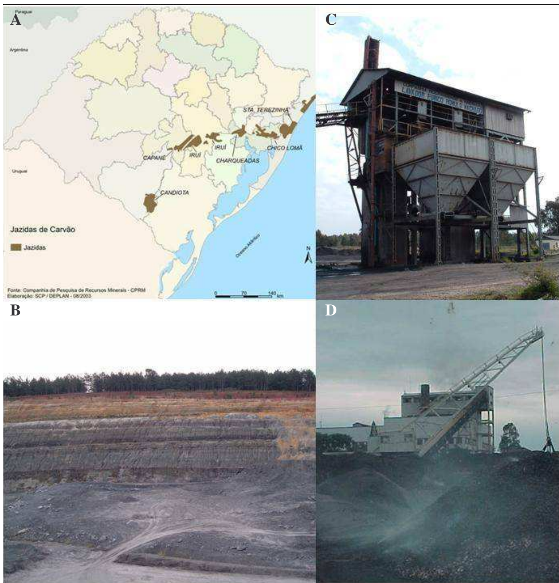
Figura 1. (A) Localização das jazidas de carvão mineral no RS. (B) Perfil de uma mineração a céu aberto, Minas do Leão (RS). (C) Separador de carvão dos Rejeitos. (D) Campo de resíduos de mineração no Pátio da Termelétrica de São Jerônimo (RS).
