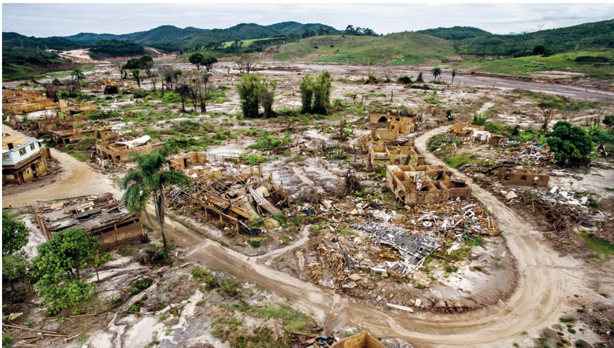
Figura 1 – Destruição em Bento Rodrigues
