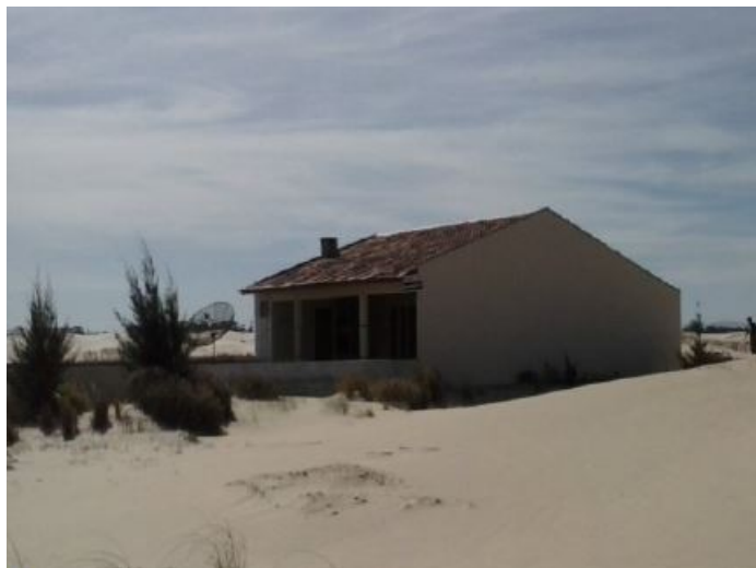
Figura 27: Residência sobre dunas no município de Jaguaruna (SC). Fonte: CECO-IGEO/UFRGS, 2013.
