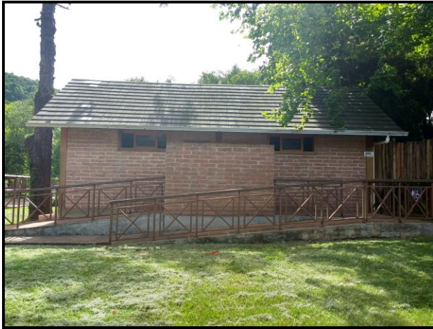
Banheiro Vista frontal
