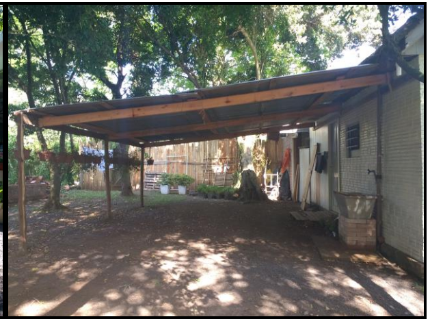
Telheiro da cozinha Vista lateral
