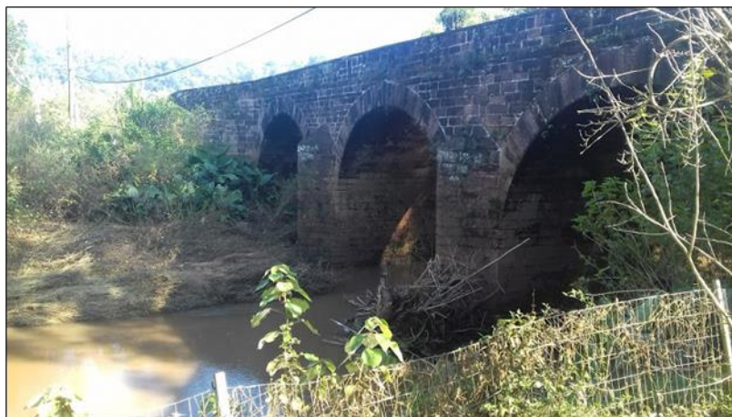
Figura 4 - Ponte do Imperador
