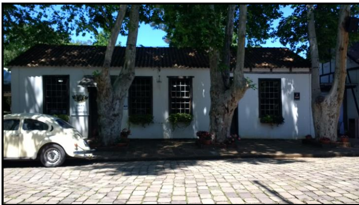
Casa do Artesão Vista frontal
