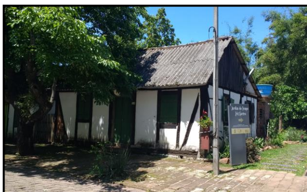
Residência Vista lateral
