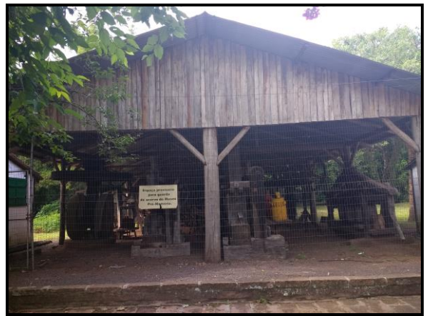
Galpão de Máquinas Vista frontal
