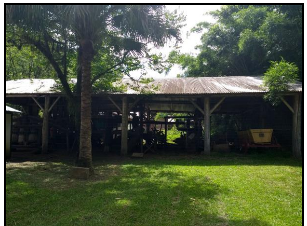
Galpão de máquinas Vista lateral
