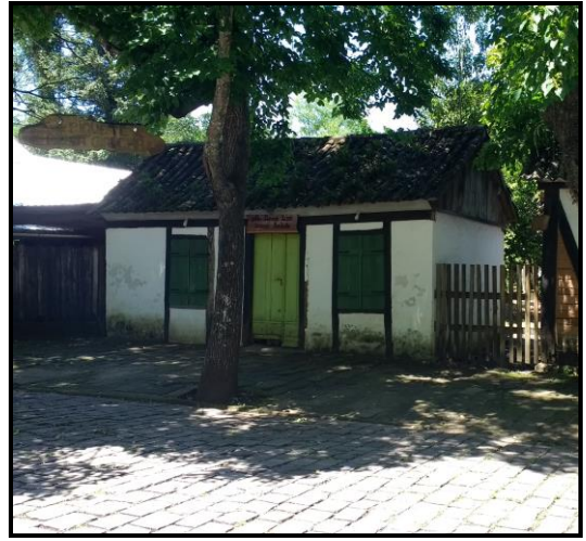
Residência Vista lateral
