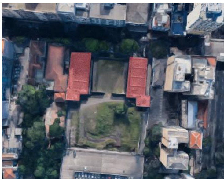
Figura 15. Edificações a ser demolidas
