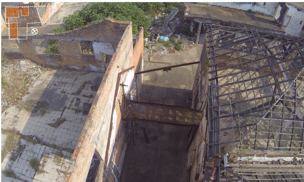
Vista Aérea - vão entre os bens nº201 e nº145 na Rua Almirante Barroso
