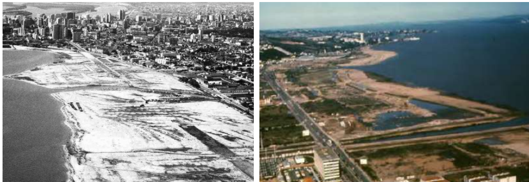
Aterro da Praia de Belas nas décadas de 60 e 70. Fonte: Vitruvius
