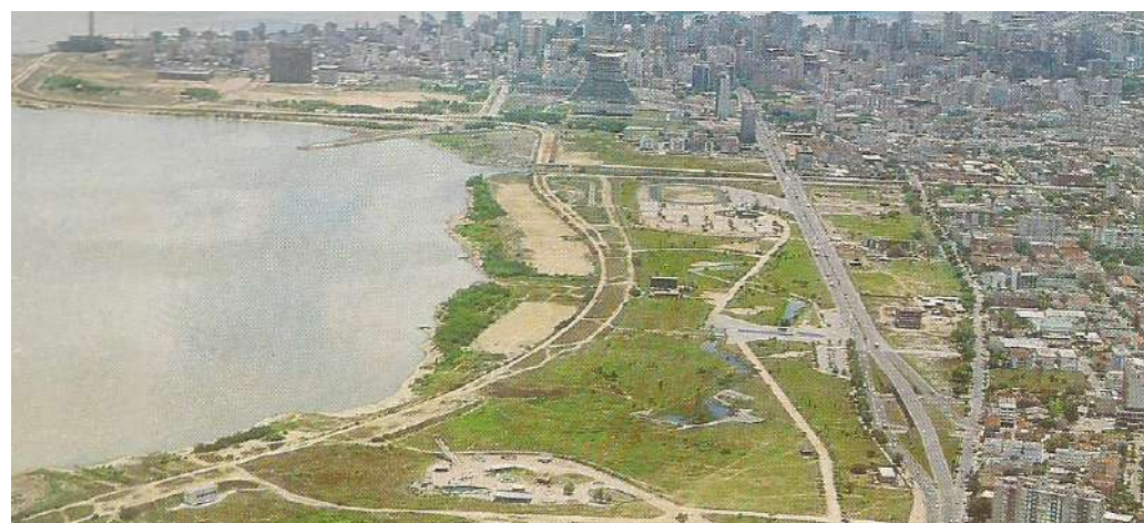
Início das obras do Parque Marinha do Brasil sobre o Aterro Praia de Belas.
