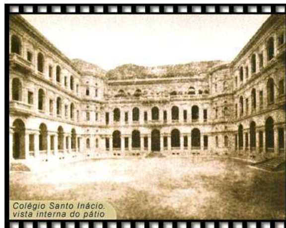
Prédio onde funcionou a Faculdade Católica de Direito do Distrito Federal que teve Autorização concedida em 1940 e Reconhecimento em 1946, quando foi transformada em Universidade Católica.
