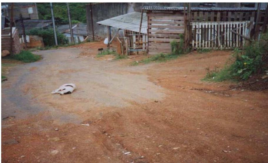
Foto 39 – O asfalto incompleto como facilitador da erosão na encosta
