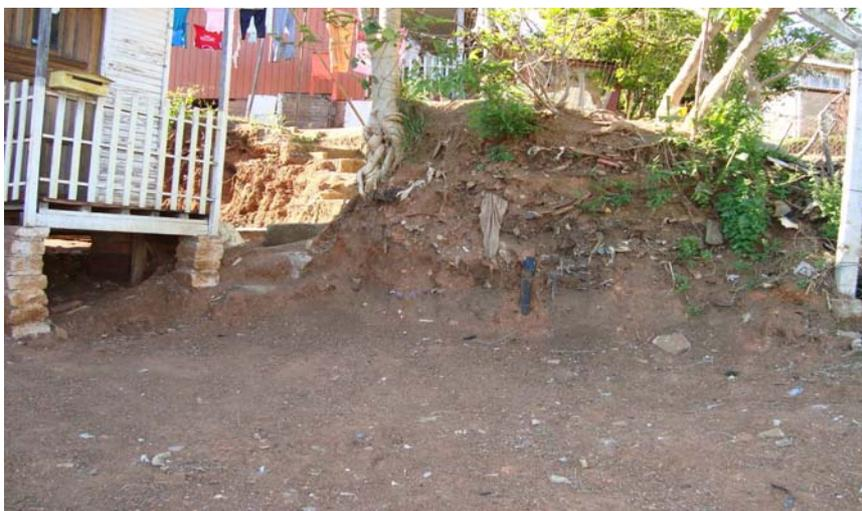
Foto 28: **Baixo padrão construtivo das moradias e cortes no terreno com presença de material tecnogênico**
