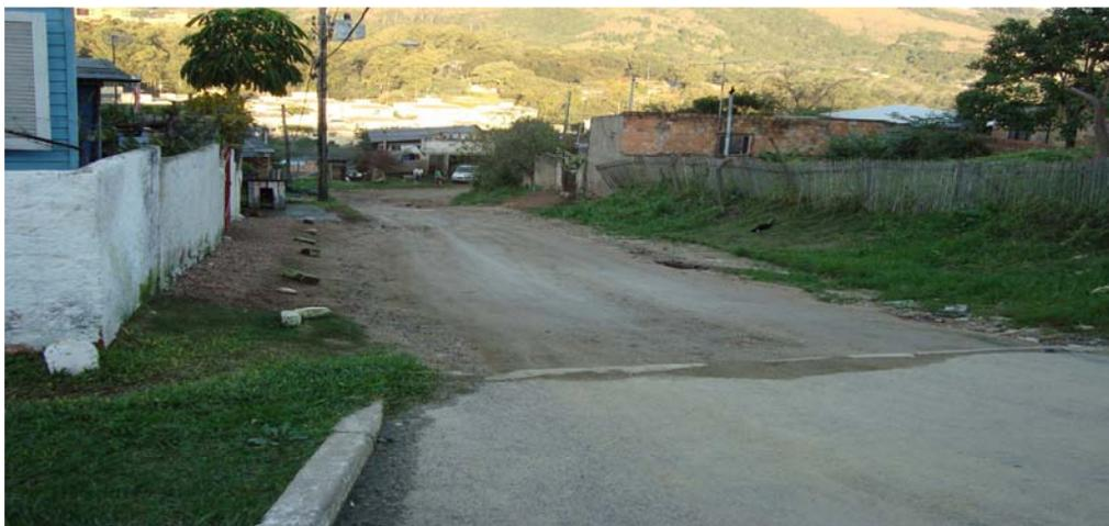
Foto 36: **Encontro de vias asfaltadas com vias sem asfalto favorece a erosão em sulcos**
