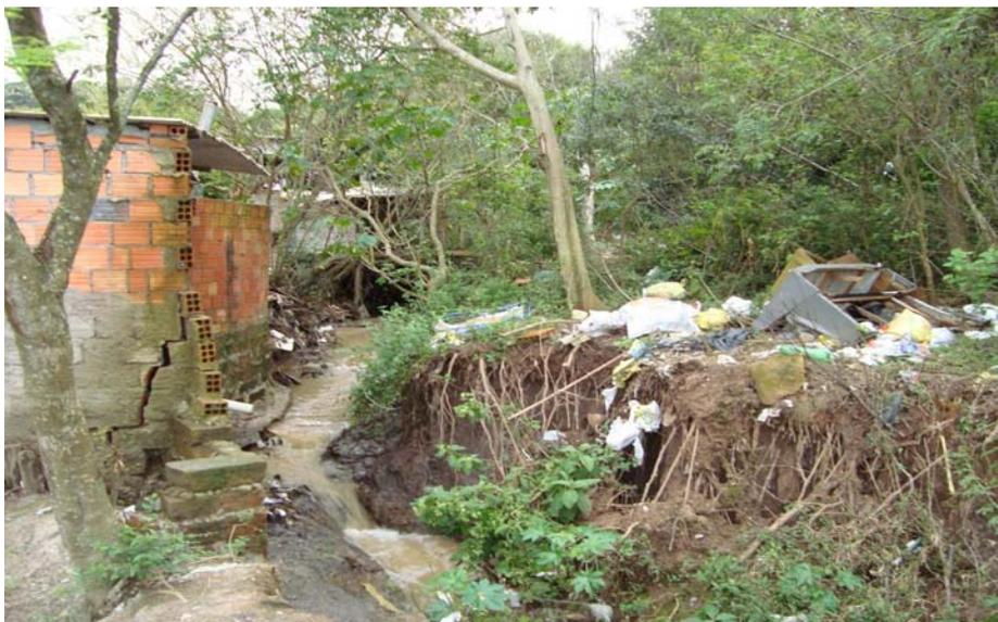
Foto 40: **Solapamento das margens do arroio devido ao estrangulamento da sua calha fluvial**
