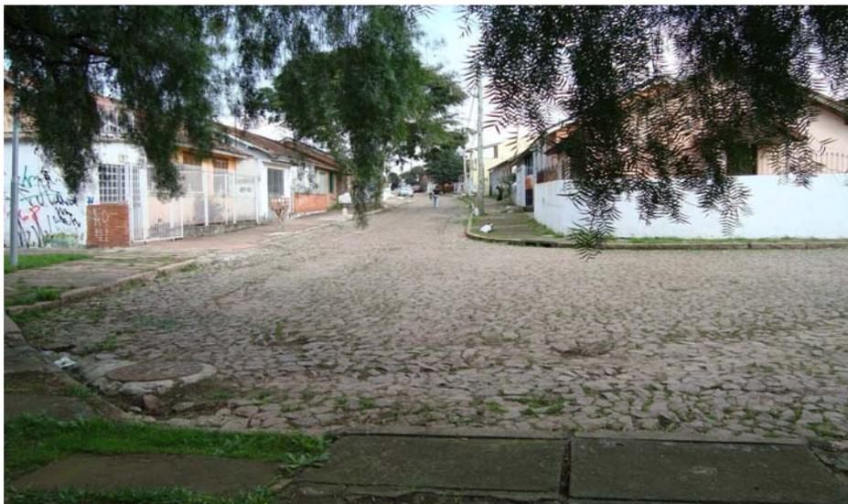
Foto 33: **Revestimento com paralelepípedos na vias planas da vila Ipê II**
