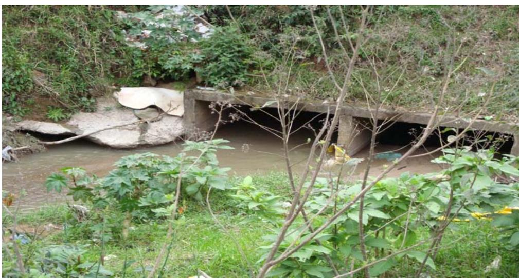
Foto 41: **Exutório da sub-bacia pesquisada, apresentando fundo raso devido à deposição de sedimentos**
