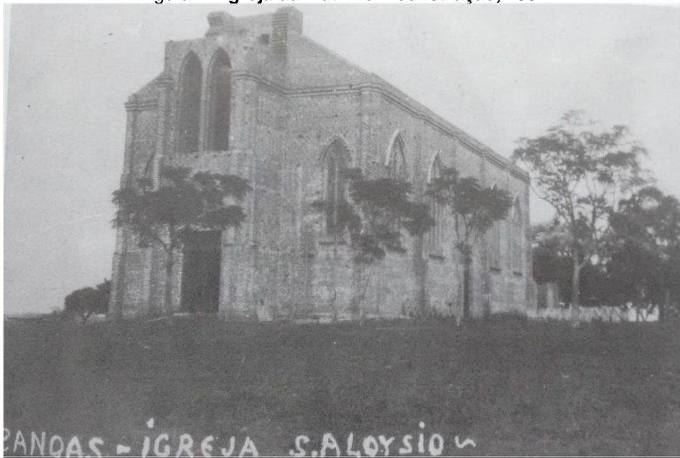
Figura 4 - Igreja da Matriz em construção, 1931
