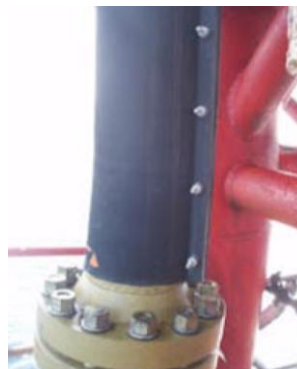
Figura 13 – Produto Armawrap instalado em um riser
