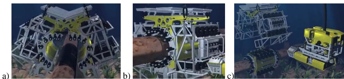
Figura 25 – Ferramenta submarina de instalação de braçadeira de reparo em risers rígidos controlada remotamente: a) Acoplamento da braçadeira no riser ; b) Aperto dos parafusos da braçadeira executada por ROV; c) Instalação da braçadeira concluída e desacoplamento da ferramenta
