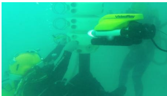
Figura 21 – Instalação do produto Armadillo da empresa Flexlife em um riser flexível danificado
