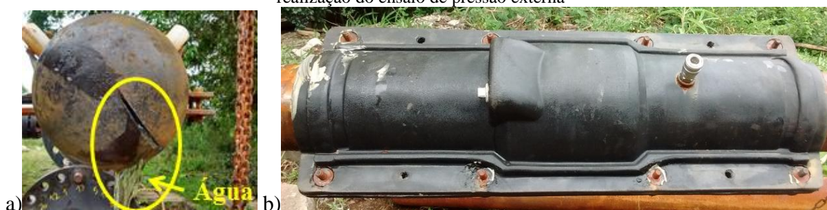
Figura 97 – a) Realização do corte da extremidade do duto para verificação de entrada de água; b) Clamp após a realização do ensaio de pressão externa
