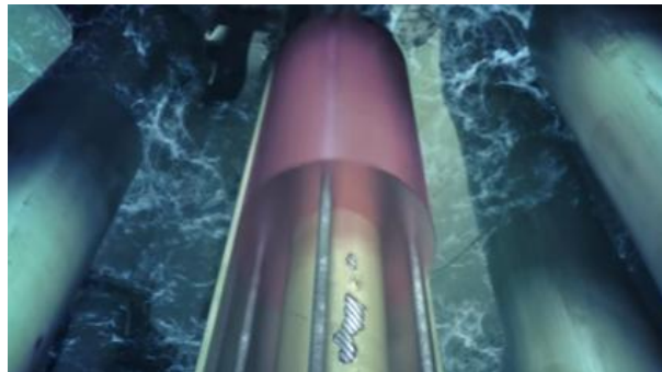
Figura 11 – Produto FlexGel sendo injetado em um reparo de dano na camada externa
