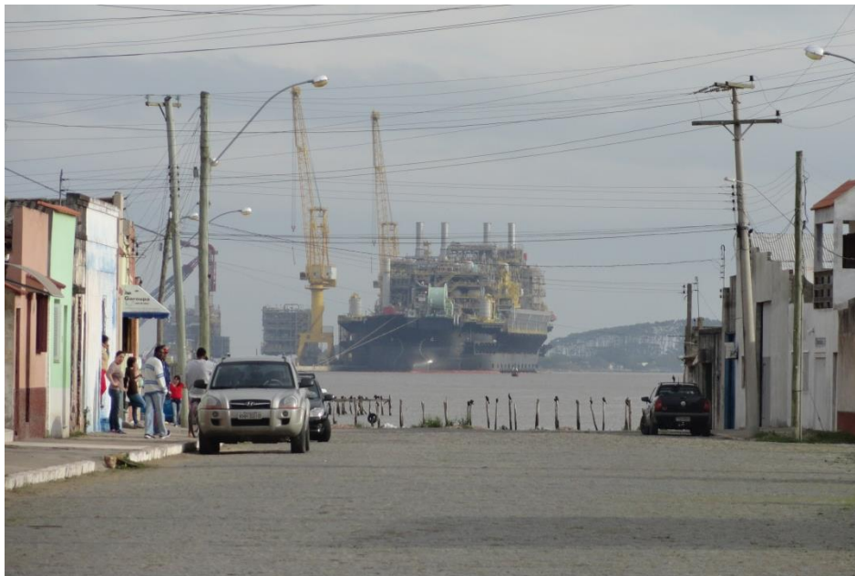
Fotografia 41: Rua Marechal Deodoro, ao fundo as obras da plataforma P-74
