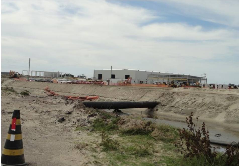
Fotografia 12: Obras de Instalação do Estaleiro EBR
