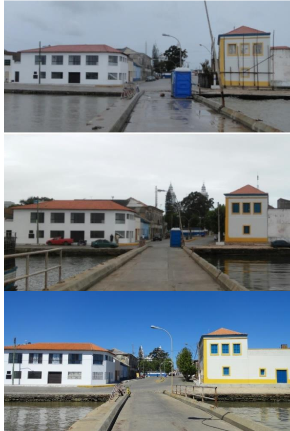
Fotografia 51: Etapas de restauração do prédio da antiga Frigoría (à direita)
