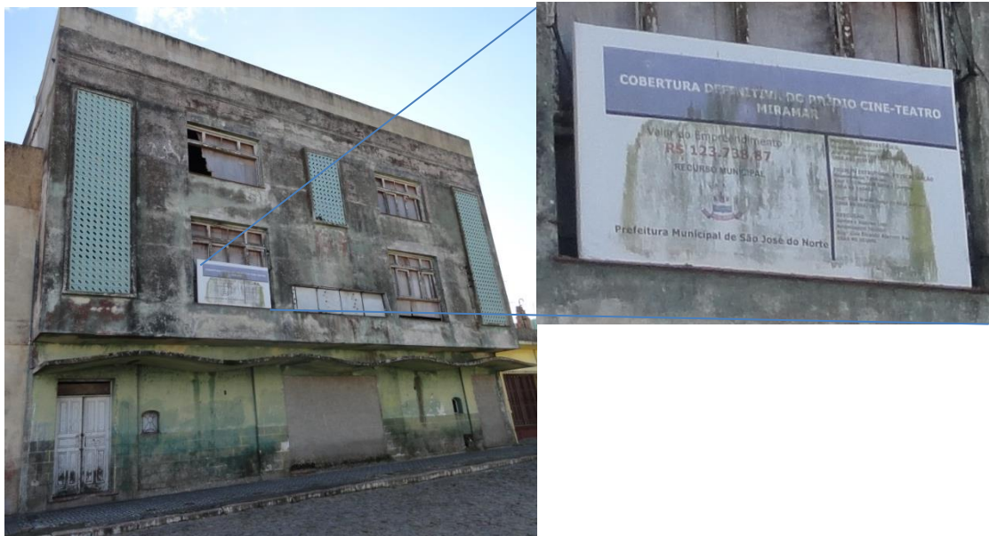
Fotografia 52: Indicação de restauração do Cine-teatro Miramar
