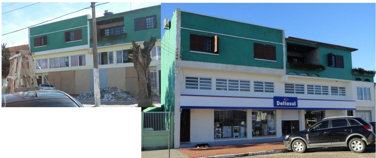
Fotografia 43: Prédio reformado para abrigar ponto comercial
