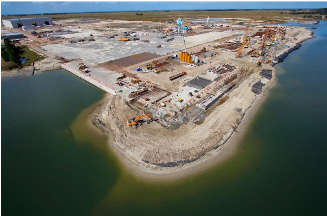
Fotografia 13: Vista aérea das obras de instalação do Estaleiro EBR
