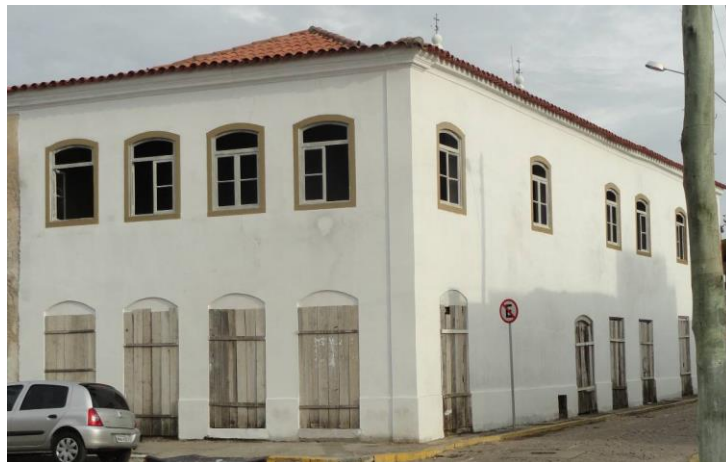
Fotografia 50: Restauração do Sobrado Gibbon
