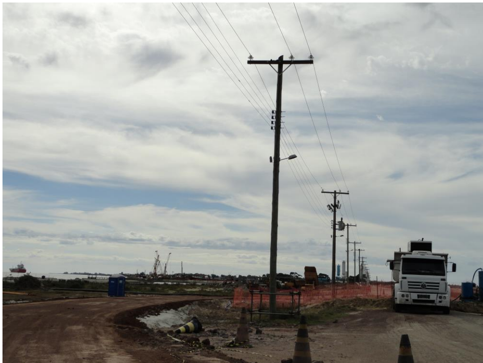
Fotografia 11: Obras de desvio da rodovia de acesso à Barra
