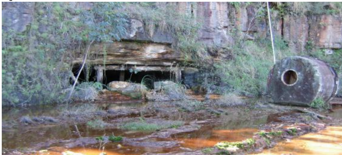
Figura 9: Boca de Mina Abandonada
