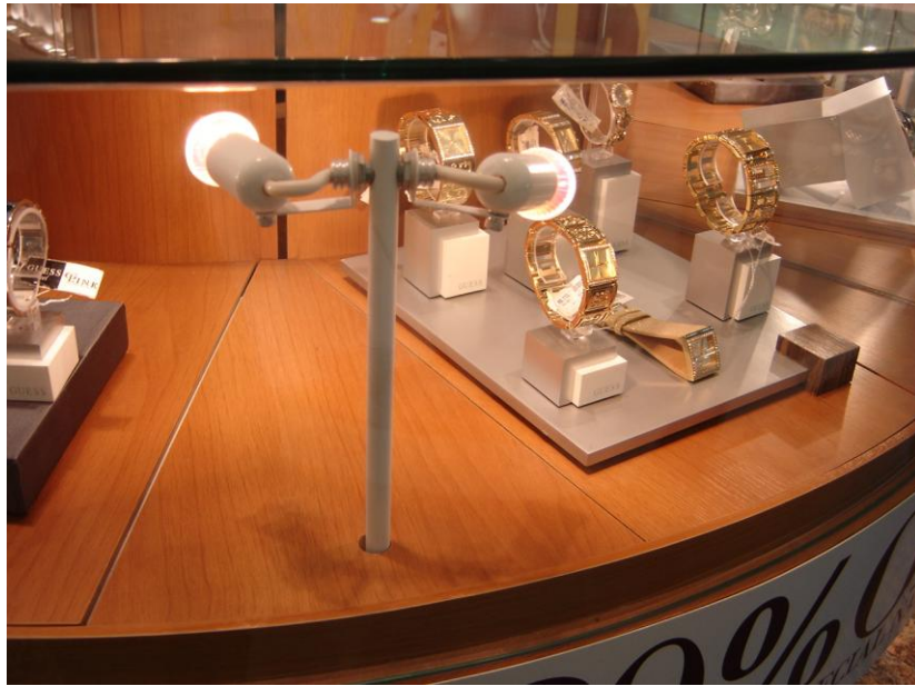
Figura 40- LUMINÁRIA INSERIDA EM MÓVEL EXPOSITOR
