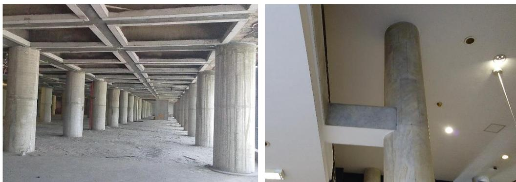
Sistema de laje nervurada, no terceiro pavimento. Mísula separando a coluna da laje do mezanino.
