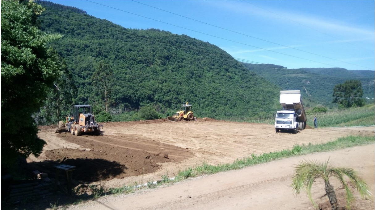
Figura 9 - Terraplanagem com apoio da Prefeitura Municipal de Nova Petrópolis que, por meio de uma política pública aplica seus trabalhos ao serviço de terraplanagem para construção de estufas.
