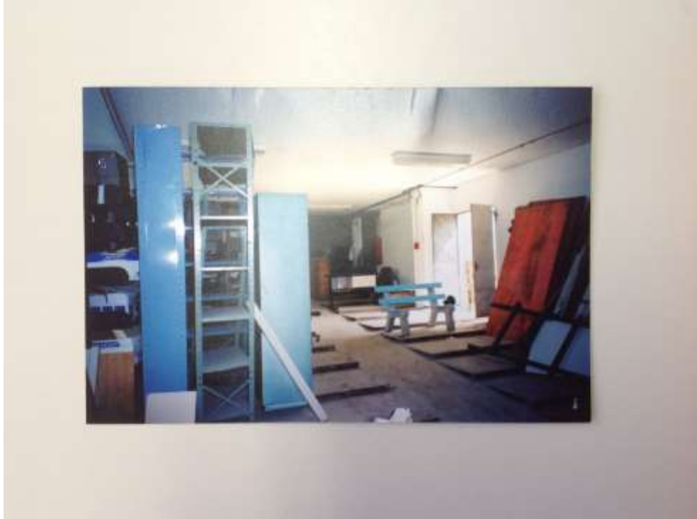
Figura 18 - Reforma e readequação do prédio cedido pelo MEC para instalação da Escola de Administração da UFRGS
