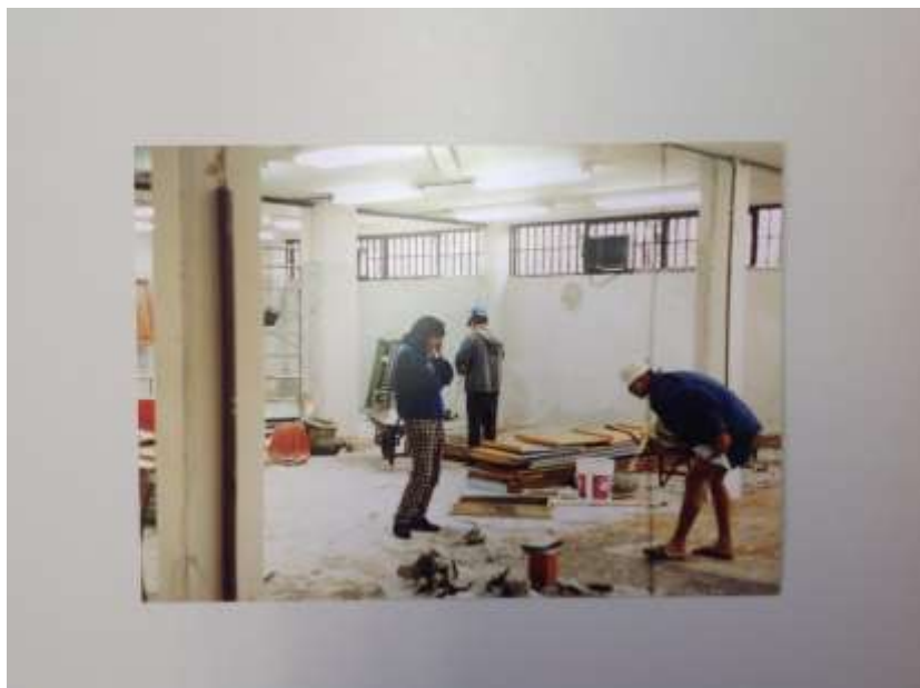
Figura 17 - Adequação do prédio cedido pelo MEC para instalação da Escola de Administração da UFRGS
