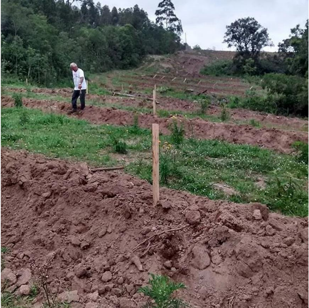
Figura 30: Alinhamento diagonal das tramas locadas (Foto do autor. Data: 19/10/2016).
