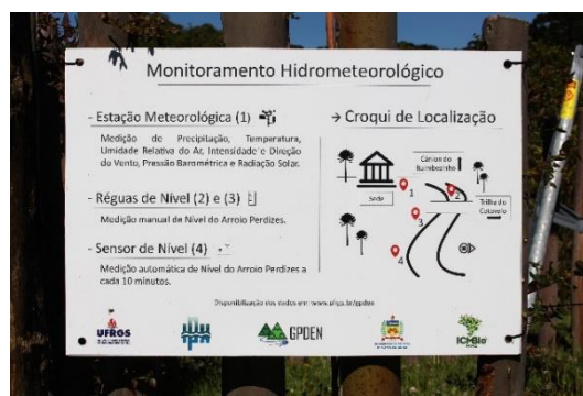
Figura 36 - Placa de Identificação do Sistema de Monitoramento
