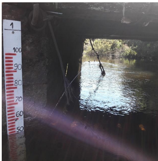
Figura 13 - Régua de Nível 1, no Leito do Arroio Perdizes, junto à Ponte da Trilha do Cotovelo.
