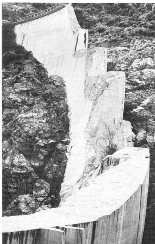
Figura 4: Ombreira direita da Barragem Malpasset após o acidente de 1959, Rio Reyran, França (JANSEN, 1983).
