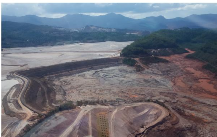
Figura 10: Barragem de Fundão, Brasil, após o rompimento de 2015 (IBAMA, 2015).
