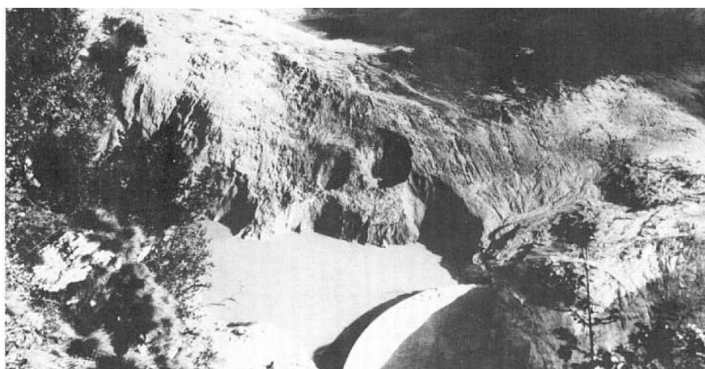
Figura 7: Vista de parte da massa de terra que colapsou no evento de 1963 da Barragem de Vajont (JANSEN, 1983).
