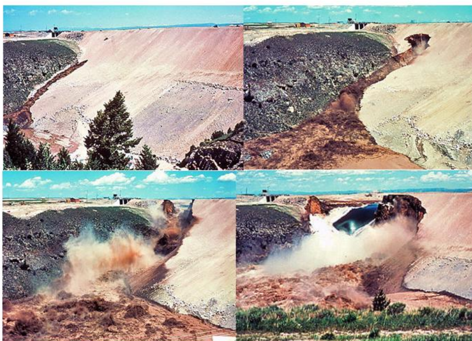
Figura 9: Sequência de imagens do rompimento da Barragem de Teton no ano de 1976, Rio Teton, EUA (adaptado de SYLVESTER, 2003).
