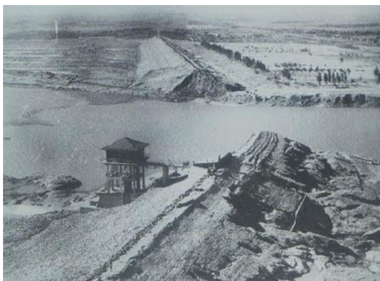
Figura 8: Barragem de Banqiao após o acidente de 1975, Rio Huai, China (INTERNATIONAL RIVERS, 2013).
