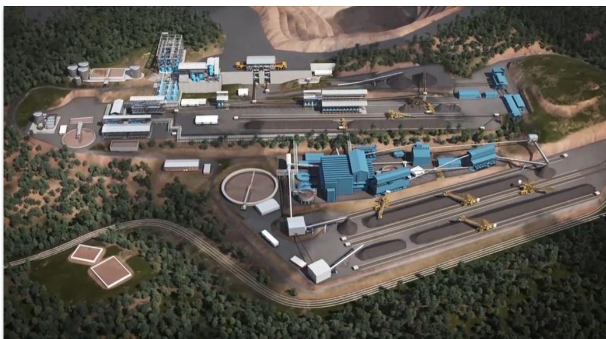
Figura 5.12- Construção dos circuitos de itabiritos compactos. Fonte: Acervo interno (Vale S.A.)
