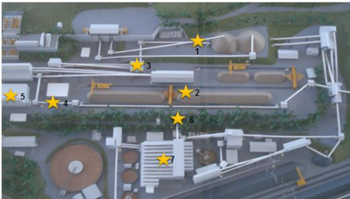
Figura 4.2 - Vista superior em 3D do Tratamento de Minérios de Conceição 1.
