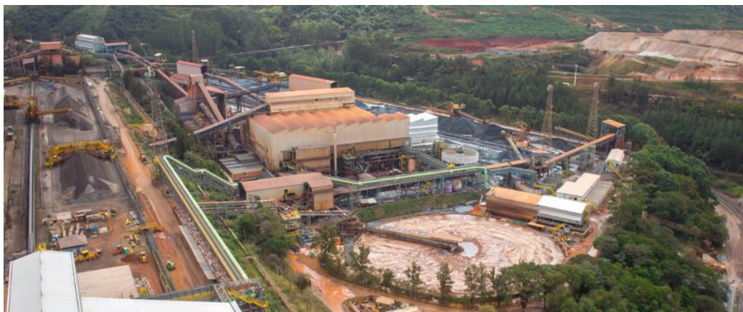
Figura 4.1 - Conceição 1 antes do projeto de Adequação. Fonte: Acervo interno Minas de Itabira (Vale S.A.)
