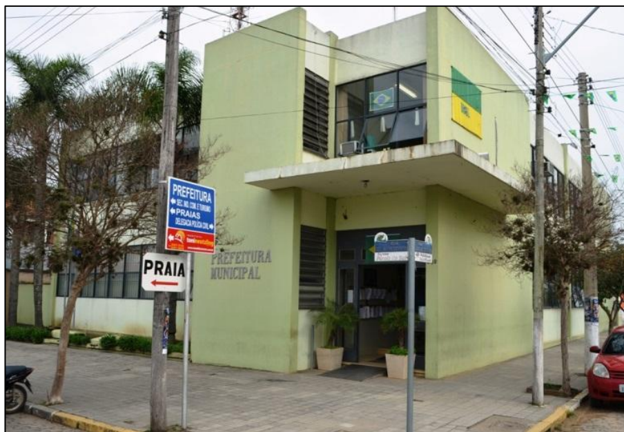
Figura 7: Fachada da Prefeitura Municipal de São Lourenço do Sul
