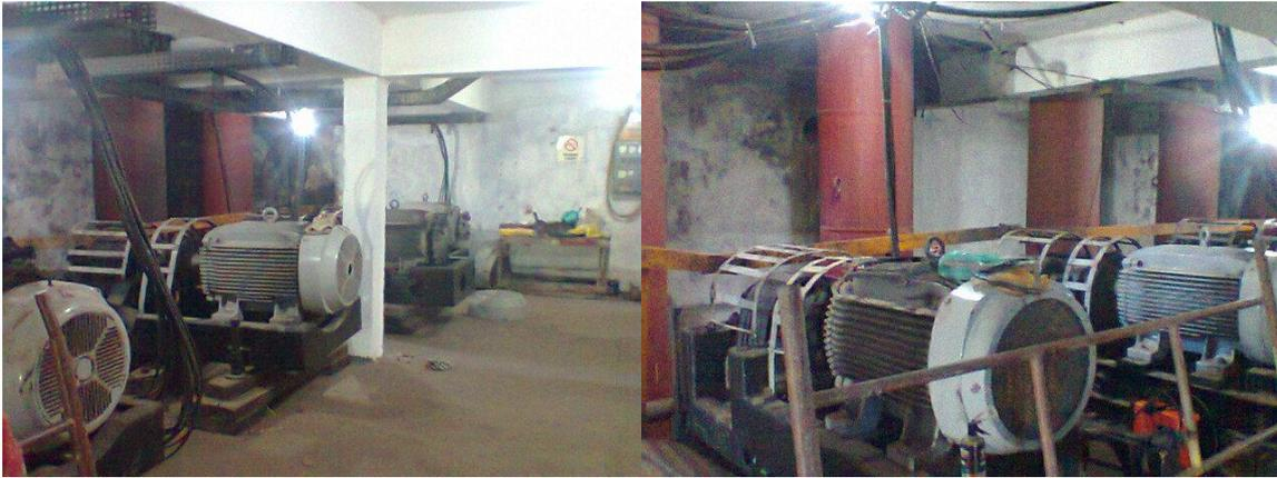
**Figura 14:** Casa de máquinas/ motores que realizam o bombeamento para puxar água da Lagoa Mangueira para a irrigação, as tubulações em vermelho são as comportas da Figura 13.
