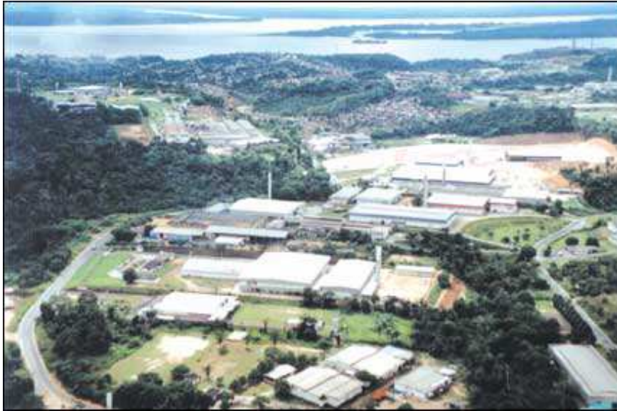
Parte da área do Distrito Industrial do PIM (Fonte: Garcia, 2004).
