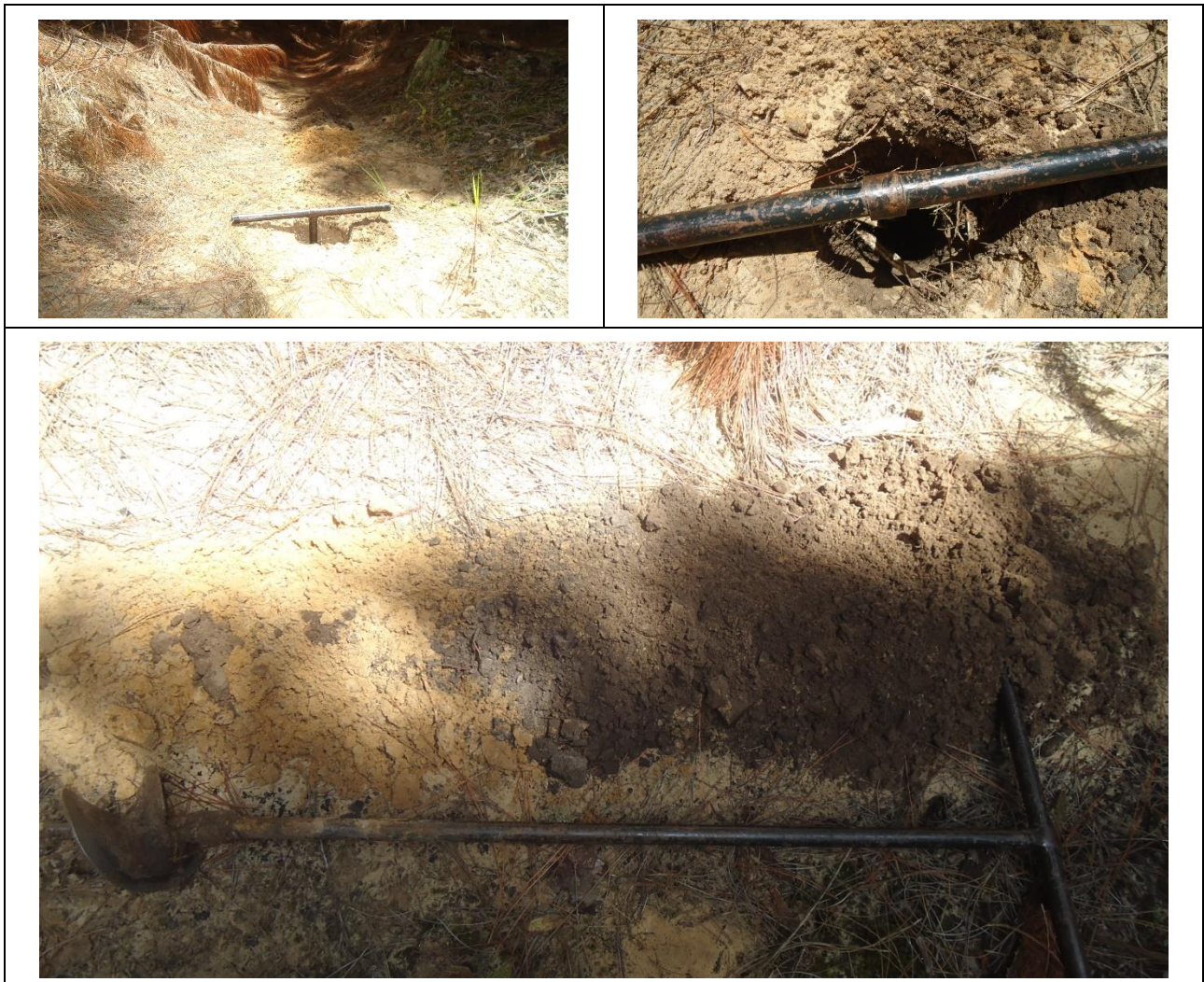
Figura 90: Detalhes do furo de sondagem S04.
