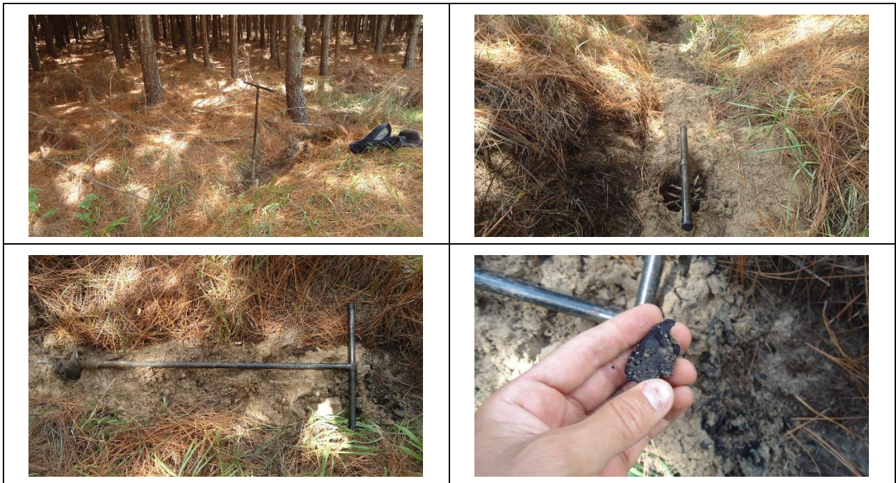
Figura 91: Detalhes do furo de sondagem S05 e do material encontrado.
