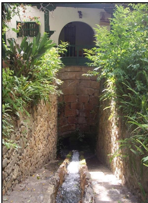
Figura 12: Sistema de condução da água até a estrutura principal do moinho
