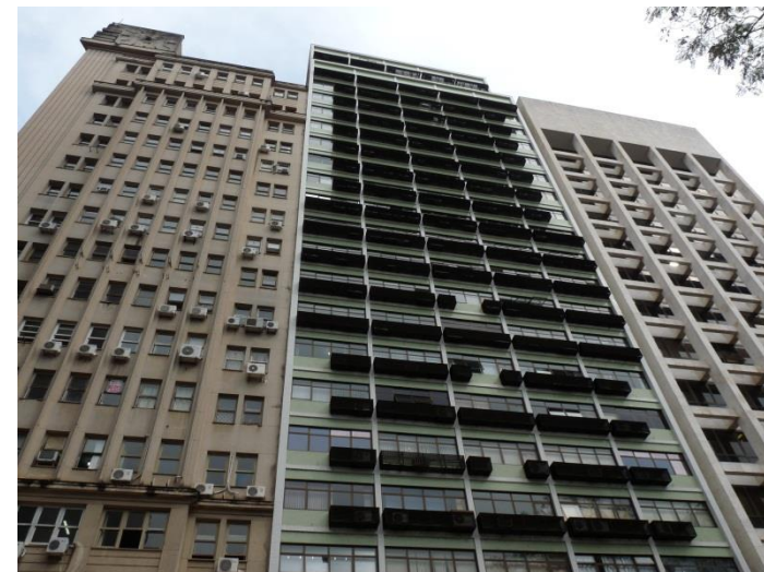
Figura 157 - Edifícios Chaves Barcelos, Di Primio Beck e Chase Manhattan (2015) Fonte: foto da autora
