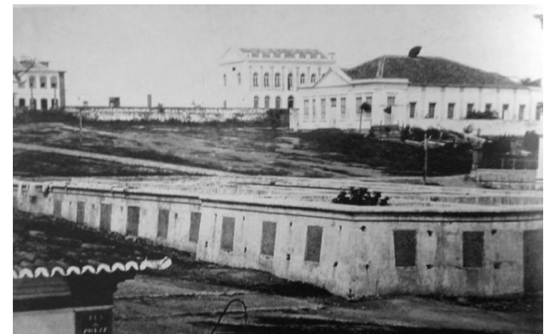
Figura 44 - Praça da Matriz – Fundações da Casa de Câmara
