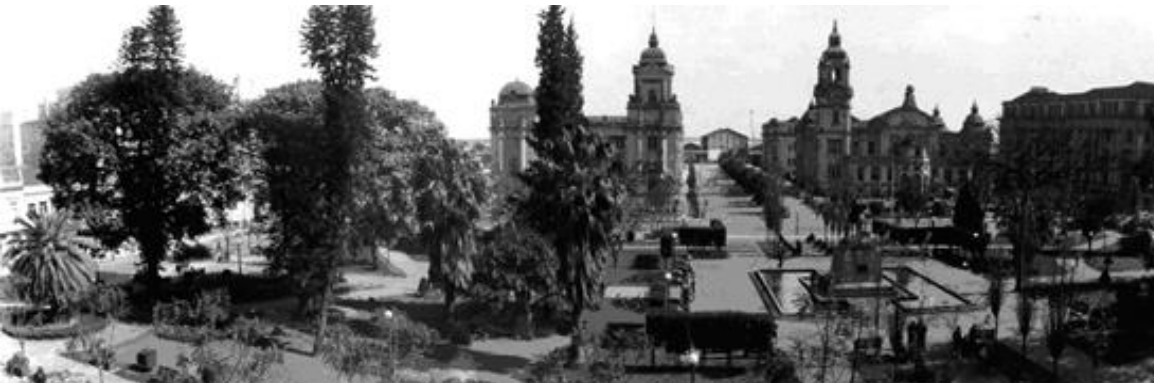
Figura 113 - Praça da Alfândega (final 1920) – ao fundo, edifícios da nova Delegacia Fiscal e dos Correios e Telégrafos. Fonte: http://lealevalerosa.blogspot.com.br/2010/04/projeto-monumenta.html
