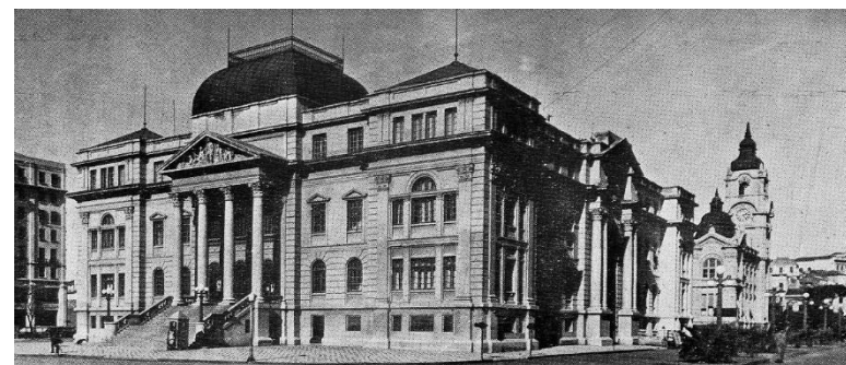
Figura 135 - Secretaria da Fazenda – Fachada voltada para a Av. Mauá Fonte: http://www.prati.com.br
