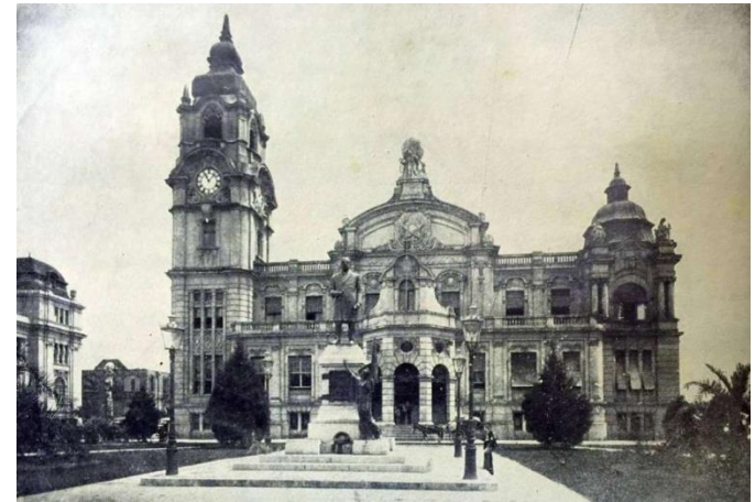
Figura 119 - Correios e Telégrafos (1940) Fonte: http://prati.com.br/porto-alegre-correios-e-telegrafos-decada-1940/
