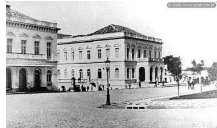
Figura 41 - Casa de Câmara ao lado do Teatro São Pedro (por volta de 1920)
