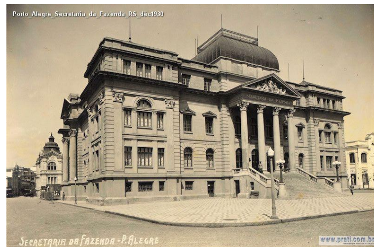
Figura 136 - Secretaria da Fazenda – Fachada voltada para a Av. Mauá. Fonte: http://www.prati.com.br
