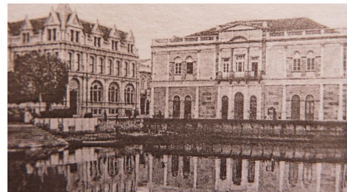
Figura 85 - Edifício da Caixa Econômica e Sede da Delegacia Fiscal antes do aterro. Fonte: EZEQUIEL, 2007, p.135
