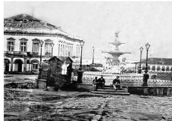
Figura 65 - Chafariz do Imperador e, ao fundo, o Teatro São Pedro (1867) Fonte: GIBROWSKI, 2010, p. 4
