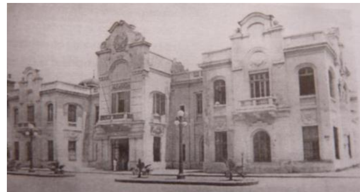
Figura 131 - Fachada principal da Nova Alfândega antes da déc. 40
