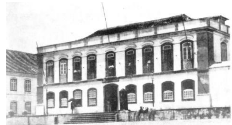
Figura 53 - Palácio do Governo após a reforma do telhado (após 1860) Fonte: CD Porto Alegre foi assim.
