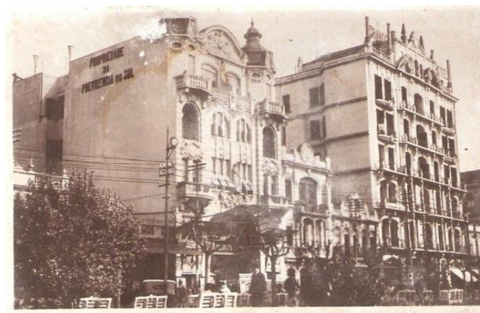
Figura 142 - Primeira fase construída do Grande Hotel (à direita)
