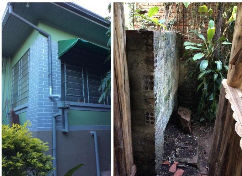
Figura 67: À esquerda, captação da água da chuva com armazenamento em cisterna; à direita, composteira.
