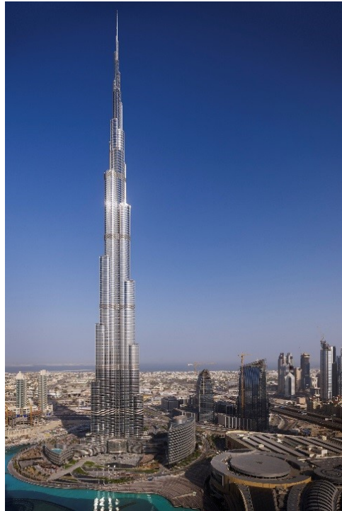
Figura 1.2 – Edifício mais alto do mundo atualmente – Burj Khalifa
