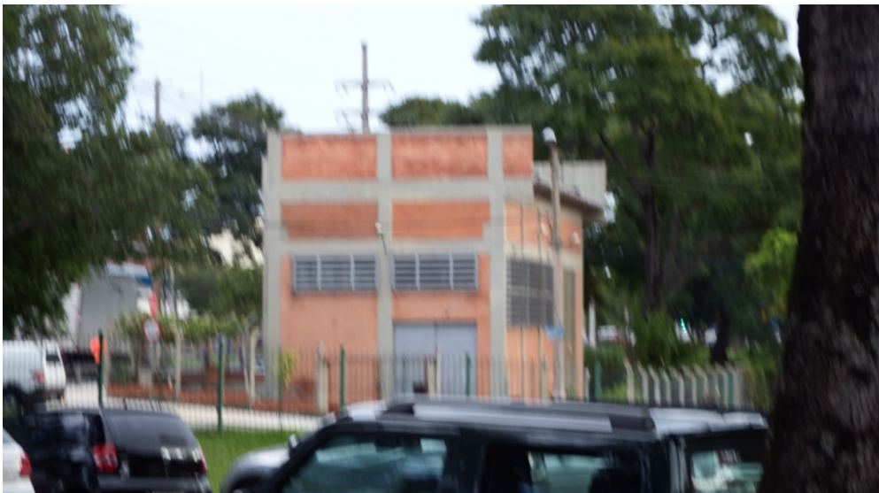
Figura 29 - Casa de bombas. Do autor.
