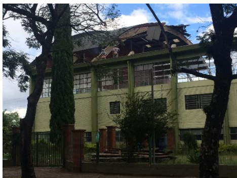
Figura 21 – cobertura danificada
