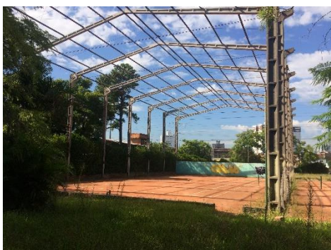
Figura 23 – desuso e abandono das quadras
