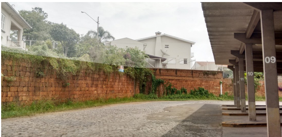
IMAGEM 06 – Muro de arrimo na interface com terrenos vizinhos
