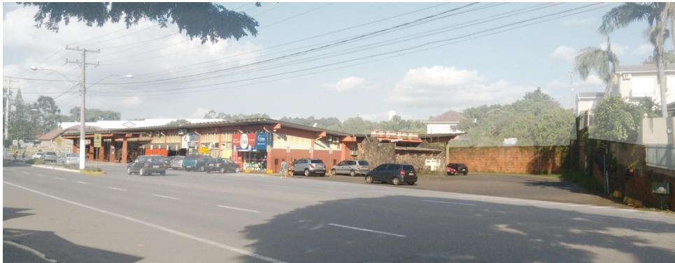
IMAGEM 05 – Estacionamento corresponde a faixa adicional já executada
