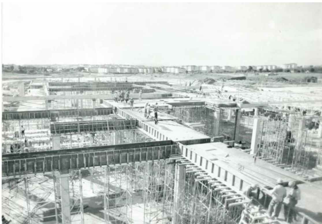
Figura 14 – A construção do SCIPA
