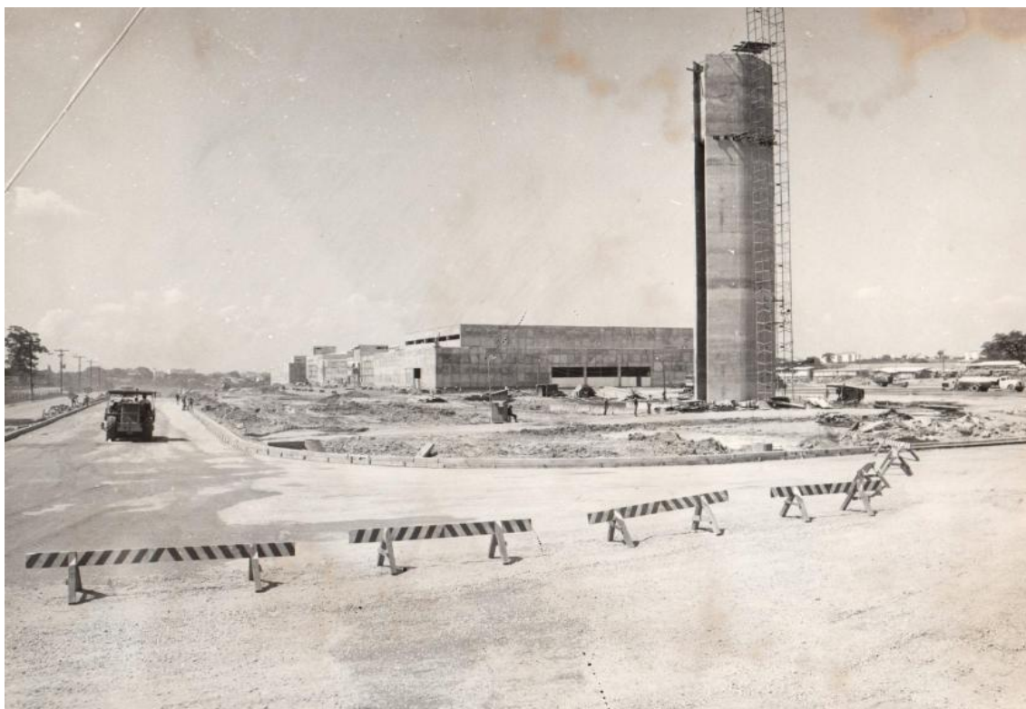
Figura 13 – Início da construção do SCIPA
