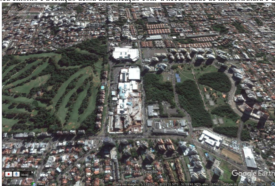
Figura 7 – Vista aérea do SCIPA em 13-5-13. Se comparada às imagens anteriores, percebe-se a alteração do imóvel e do seu entorno e a relação dessa densificação com a necessidade de infraestrutura e de serviços.
