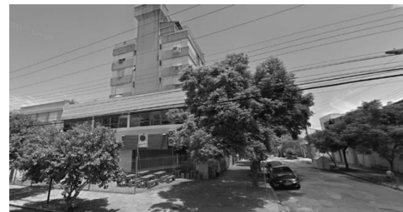
Edifício com uso misto – Rua Santana
