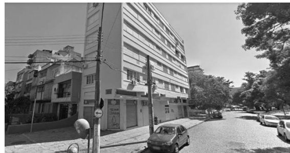
Edifício com uso misto – Rua Santana
