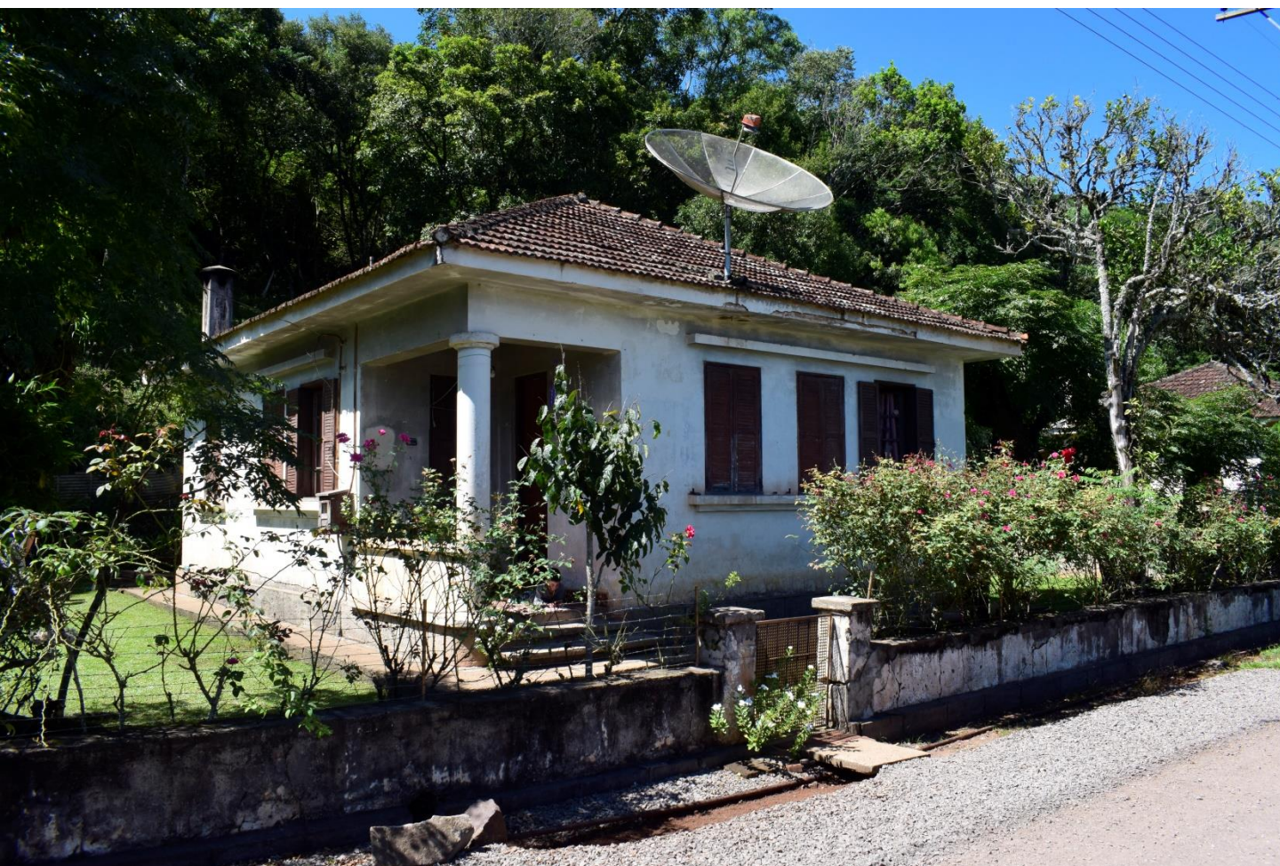
Figura 60: Aspecto de Moradia da Vila do Batalhão Ferroviário (2) Ferrovía do Vinho (Ramal Desativado). – Bento Gonçalves – 2018 Fonte: Fotografia de Yuri Rapkiewicz
