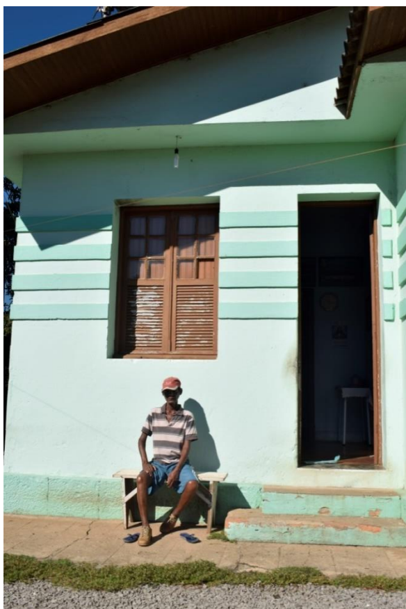
Figura 45: Casa do Batalhão Ferroviário (1), Bento Gonçalves - 2018 Fonte: Fotografia de Yuri Rapkiewicz
