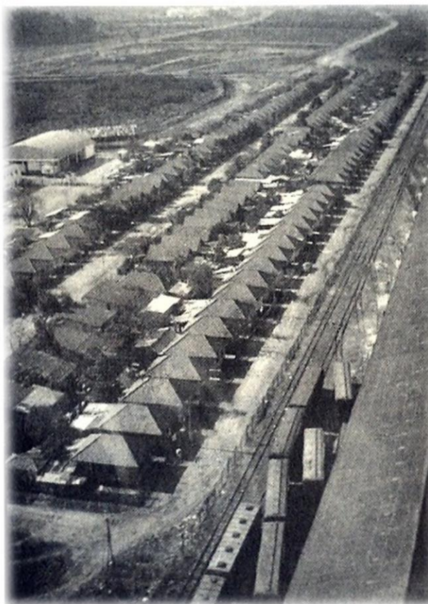
Figura 10: Vista aérea da Vila dos Ferrovieiros Fonte: PMPA/SMC, 2009
