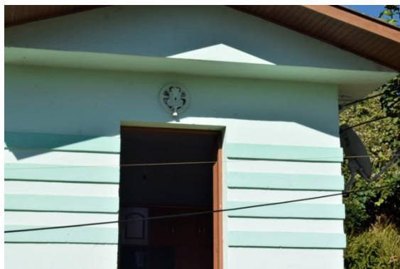
Figura 46: Casa do Batalhão Ferroviário (2), Bento Gonçalves - 2018 Fonte: Fotografia de Yuri Rapkiewicz
