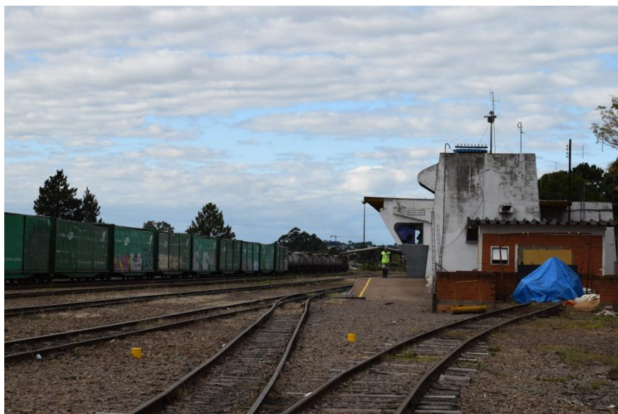
Figura 42: Aspecto Exterior da Estação Operacional de Passo Fundo – Maio de 2018 Fonte: Fotografia de Yuri Rapkiewicz
