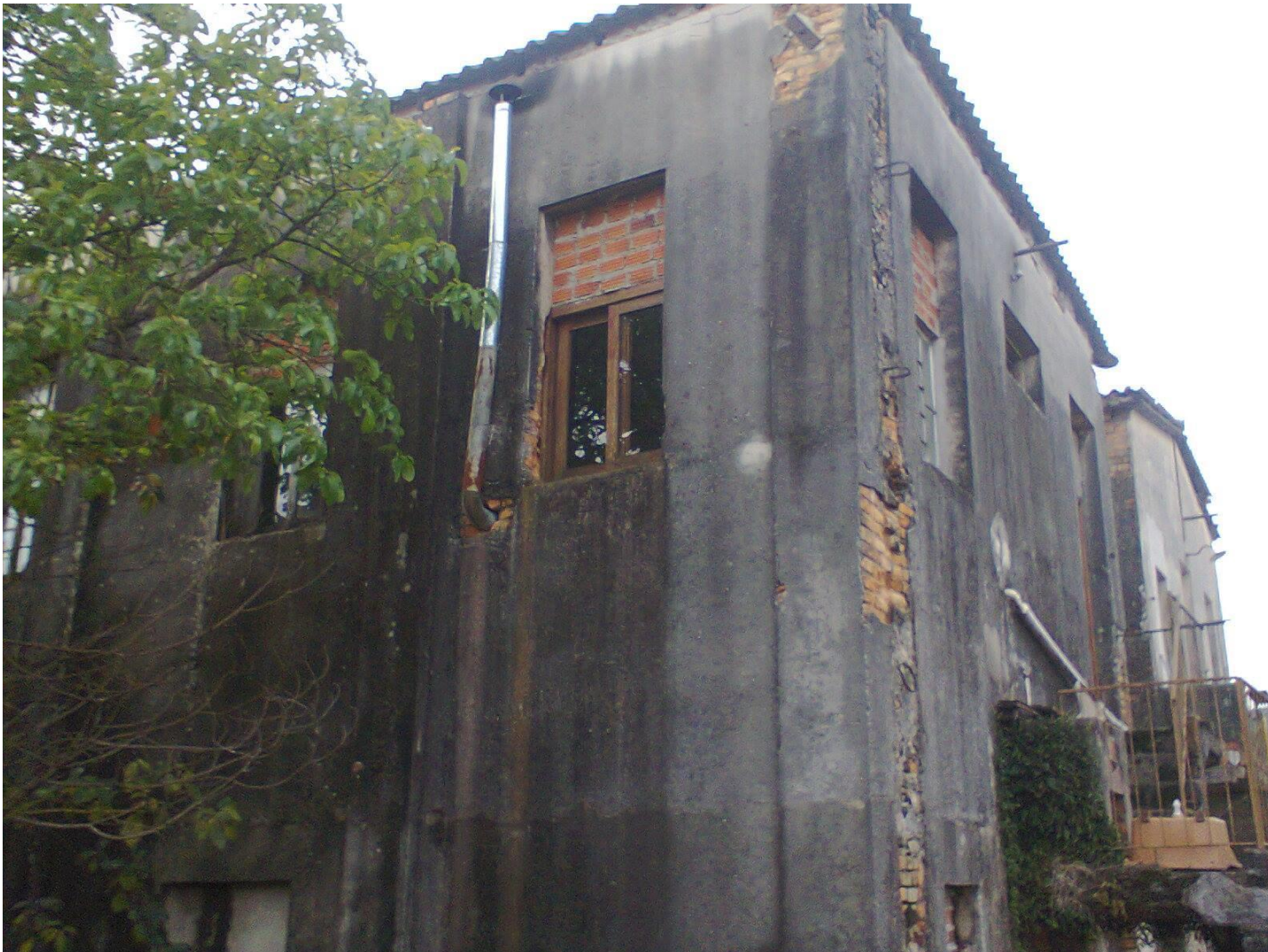
Figura 103: "Casarão da RFFSA que morei de 1972 à 1980 em Santa Maria RS."
