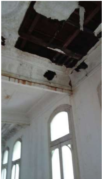
Forro no 3º pavimento
