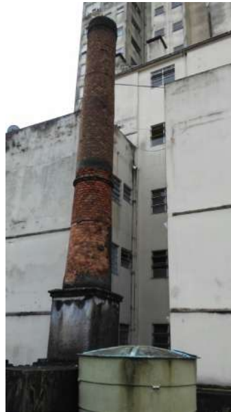
Chaminé no terraço
