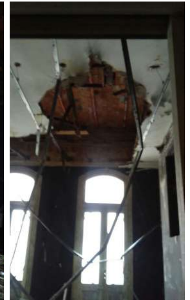
Forro no 2º pavimento
