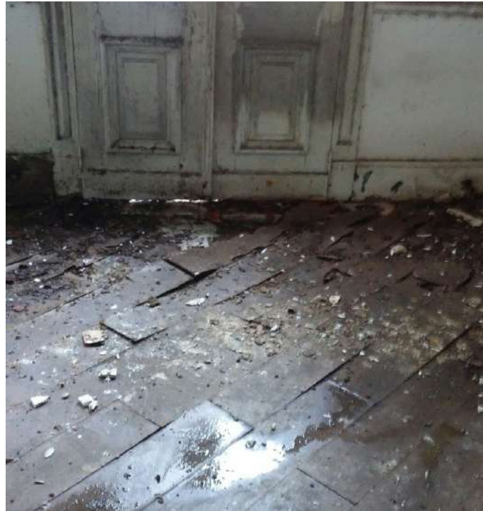
Piso de madeira no 3º pavimento
