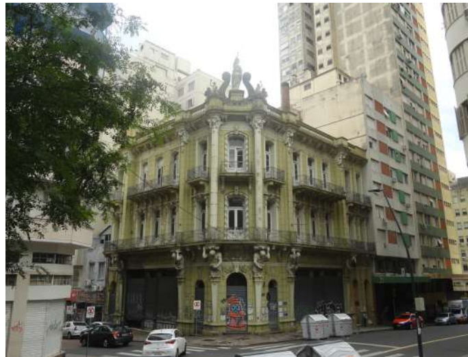
Vista geral da edificação
