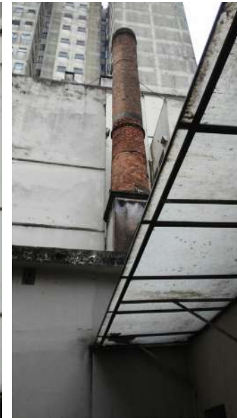
Chaminé, vista do 3º pav.
