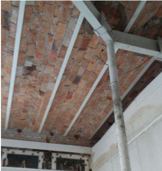
Laje no 3º pavimento
