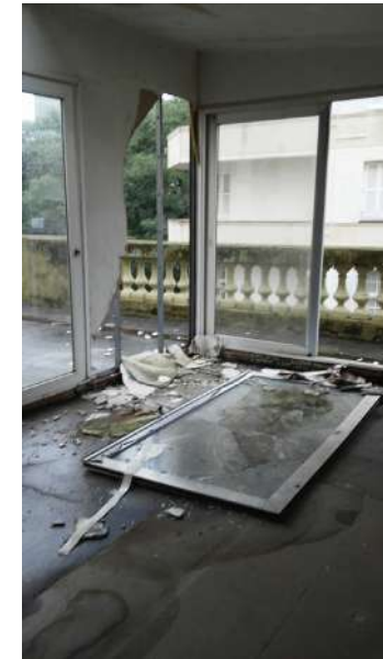
Esquadrias na cobertura
